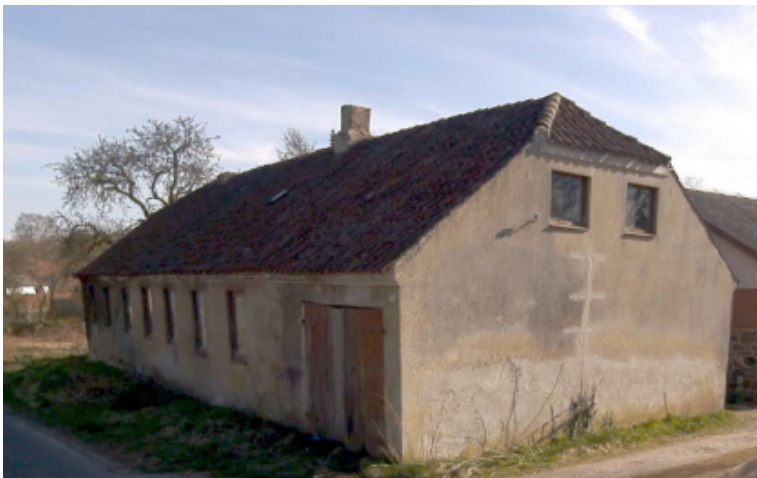
Foto af ejendommen Linågyden 7
