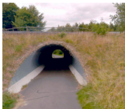
Foto af en af tunnellerne.
