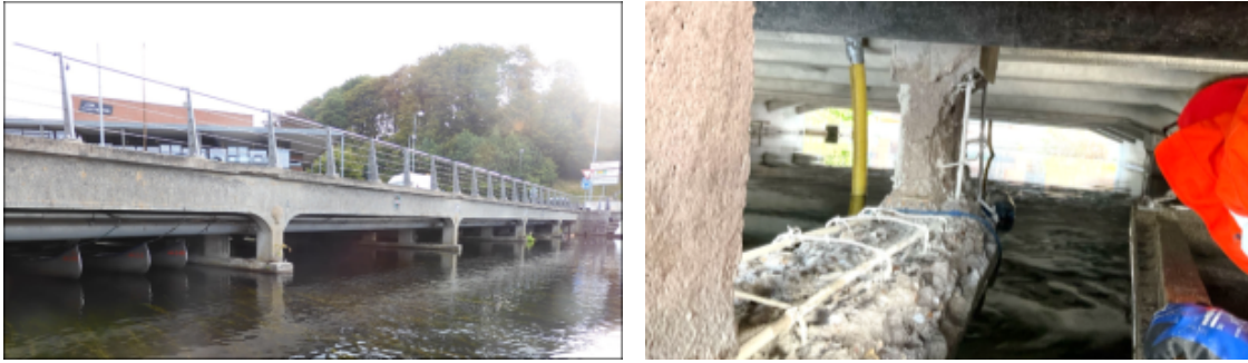
Foto: Langebro og søjle, hvor dårlig beton er fjernet og klar til genopbygning. - 2024
