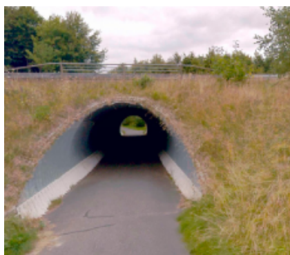
Foto af en af tunnellerne.
